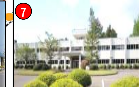
7 福島県林業研究センター (郡山市)
