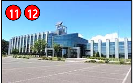
11 福島県ハイテクプラザ (郡山市) 12 エネルギー・エージェンシーふくしま (郡山市)
